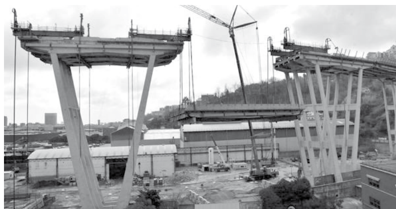
Il cantiere per la ricostruzione
